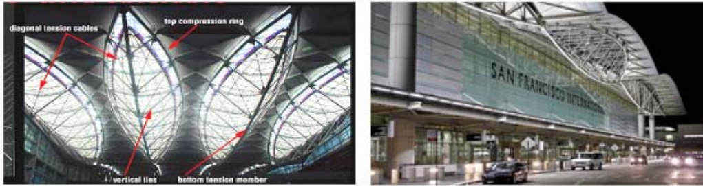
الشكل (٤) مبنى مطار سان فرانسيسكو، الولايات المتحدة، استخدام ٥ وحدات من نظام المسننات الفضائية www.SOM.com
