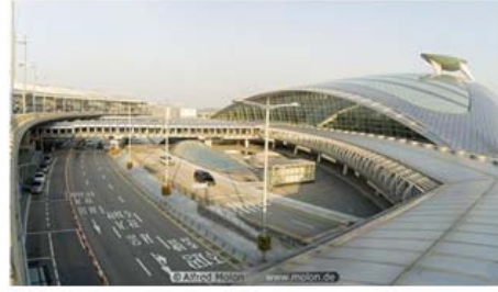
الشكل (١٤) الشكل الانسيابي في التصميم الخارجي لمركز النقل (Edwards,2005,p257)
