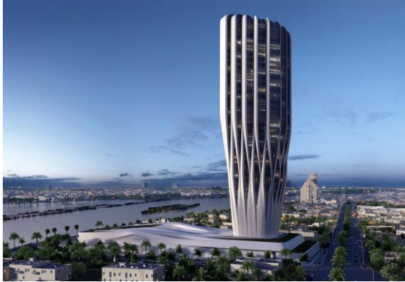
شكل -25 مبنى البنك المركزي العراقي للمعمارية زها حديد، بغداد، 2015
