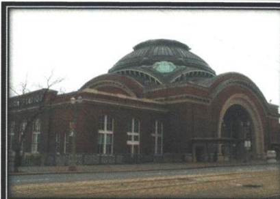
شكل ٥ : محطة تاكوما في الولايات المتحدة الامريكية و المعاد تاهيلها الى مبنى محكمة. المصدر / http://media-
